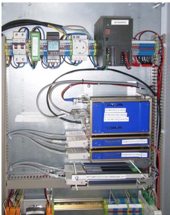
帶有量測模組的 imc CANSAS 的 imc CRONOSflex 基本單元與機櫃
