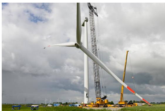
传统的转子总成安装方法正逐渐被单叶片安装技术取代- © 图: Senvion
